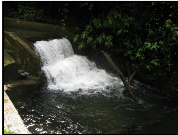
Figura 20. Bocatoma Cestillal Alto, ubicada en el sector del Manzano, cuenca alta del Río Cestillal.
