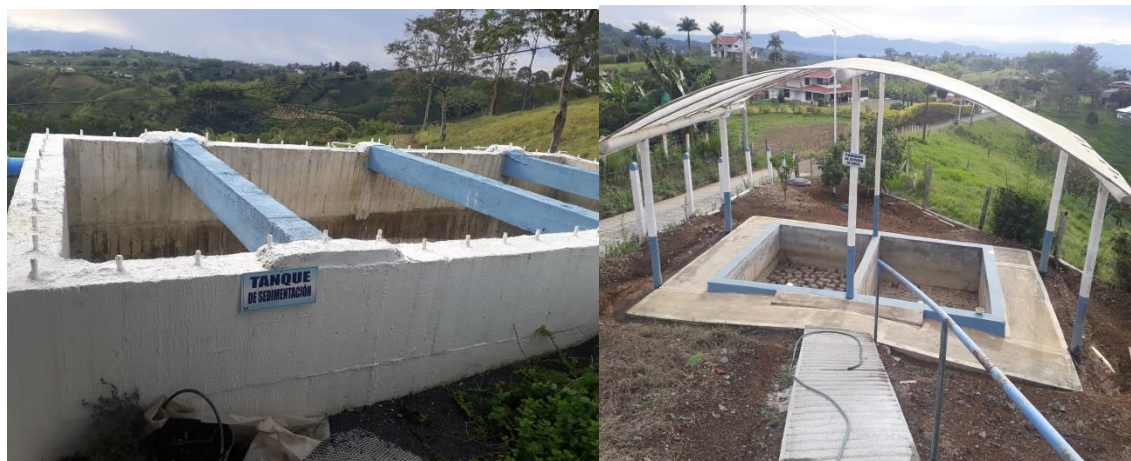
Tanque sedimentador
