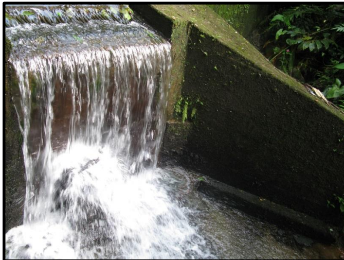
Figura 21.. Bocatoma la Montañita, tributaria del Río Cestillal en la cuenca alta.
