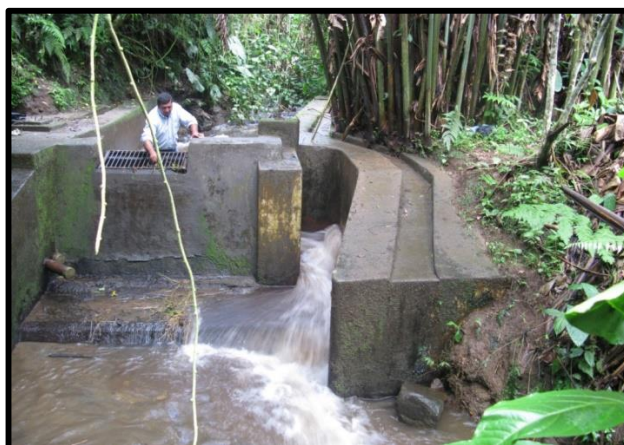
Figura 18. Bocatoma El Tesorito, ubicada en la cuenca media del Río Cestillal, a la altura de la vereda La Sonora.
